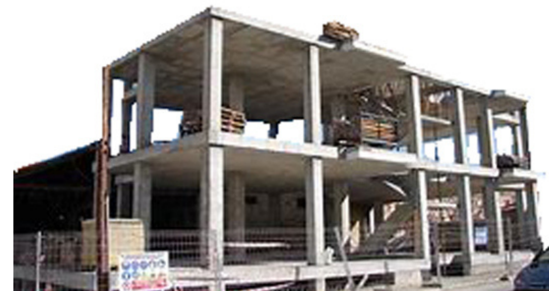
ESTRUCTURA DE VIGAS Y PILARES DE HORMIGÓN ARMADO
