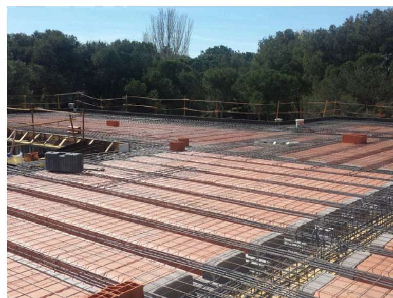
FORJADOS UNIDIRECCIONALES DE VIGUETA Y BOVEDILLA CON VIGAS Y PILARES DE HORMIGÓN ARMADO CUMPLIENDO TODAS LAS EXIGENCIAS DEL CTE.
