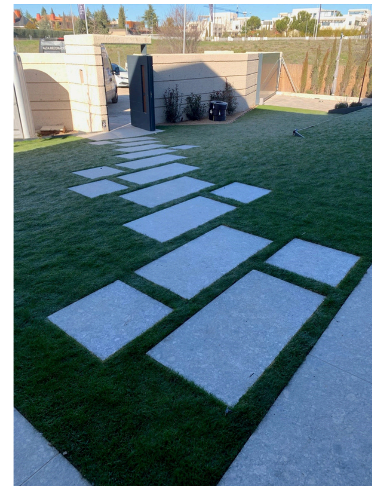
PEATONALES DE BALDOSAS DE HORMIGÓN CONCERTADAS SEGÚN DISEÑO DE PROYECTO.
