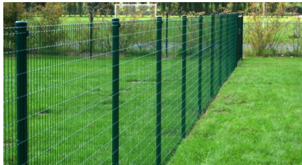
VALLADO DE CERRAMIENTO CON LA CALLE CON MALLA ELECTROSOLDADA PLASTIFICADA VERDE DE 200CM DE ALTURA
