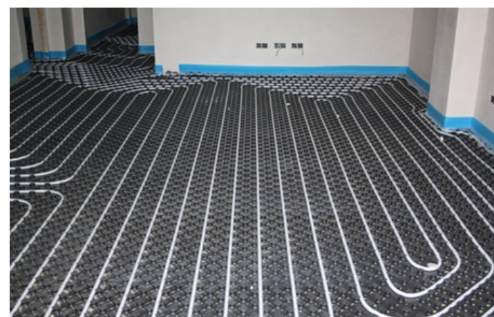
SUELO RADIANTE/REFRESCANTE EN TODA LA VIVIENDA
