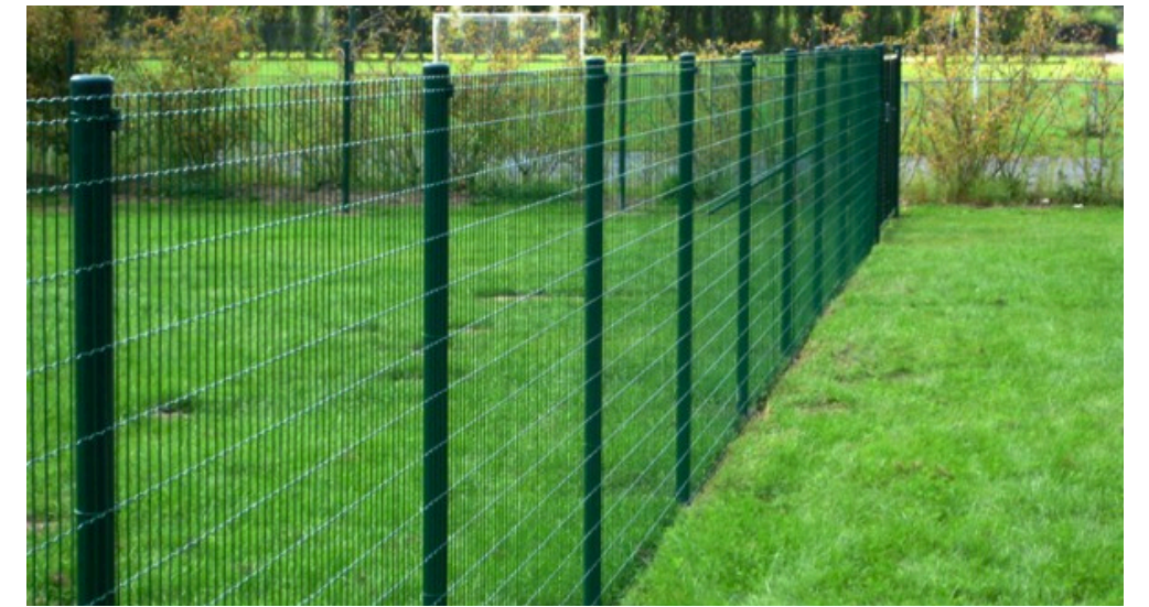
VALLADO DE SEPARACIÓN ENTRE JARDINES PRIVADOS CON MALLA ELECTROSOLDADA PLASTIFICADA VERDE DE 1.50CM DE ALTURA
